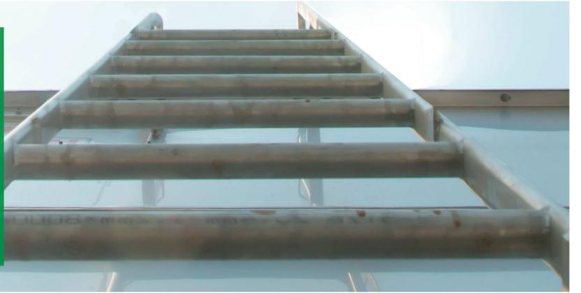
**Saviez-vous que les échelles fixes installées depuis le 3 janvier 2019 doivent être munies d'un dispositif d'arrêt de chute sur une corde d'assurance verticale tendue ou sur un rail rigide vertical ?**
