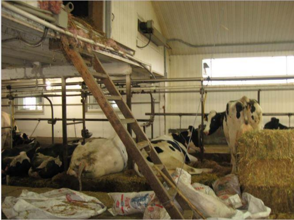
Accident – échelle sans main courante Ferme Gambler (source CNESST)
