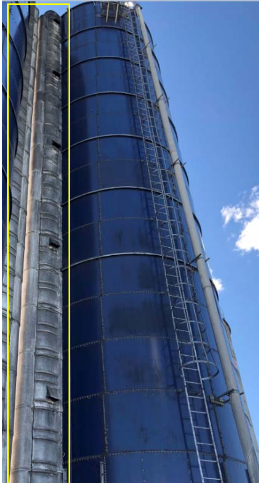
Photo 10 – Position des 17 trappes d'accès
