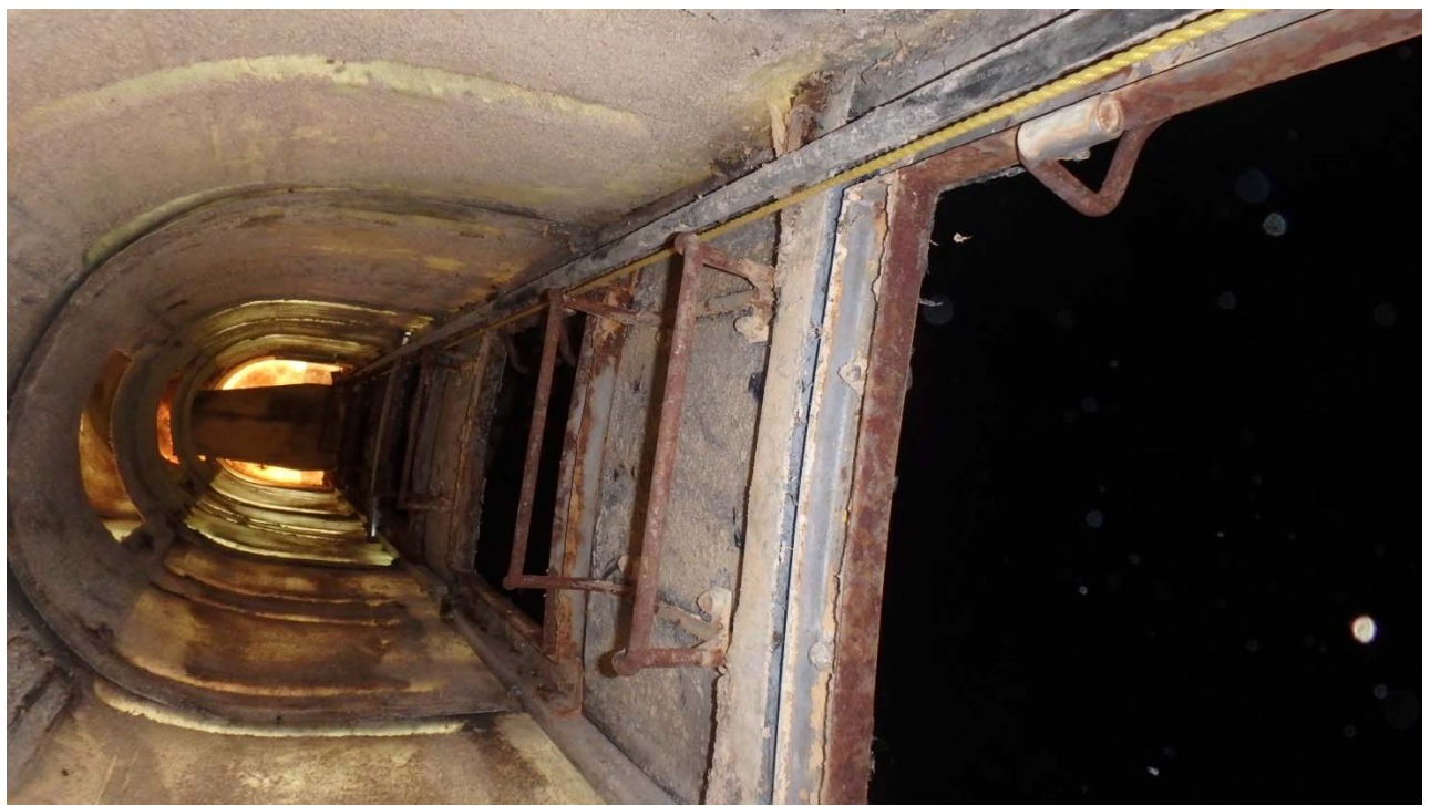
Photo 6 – Intérieur d'échelle d'accès à crinoline avec vue sur les trappes d'accès
