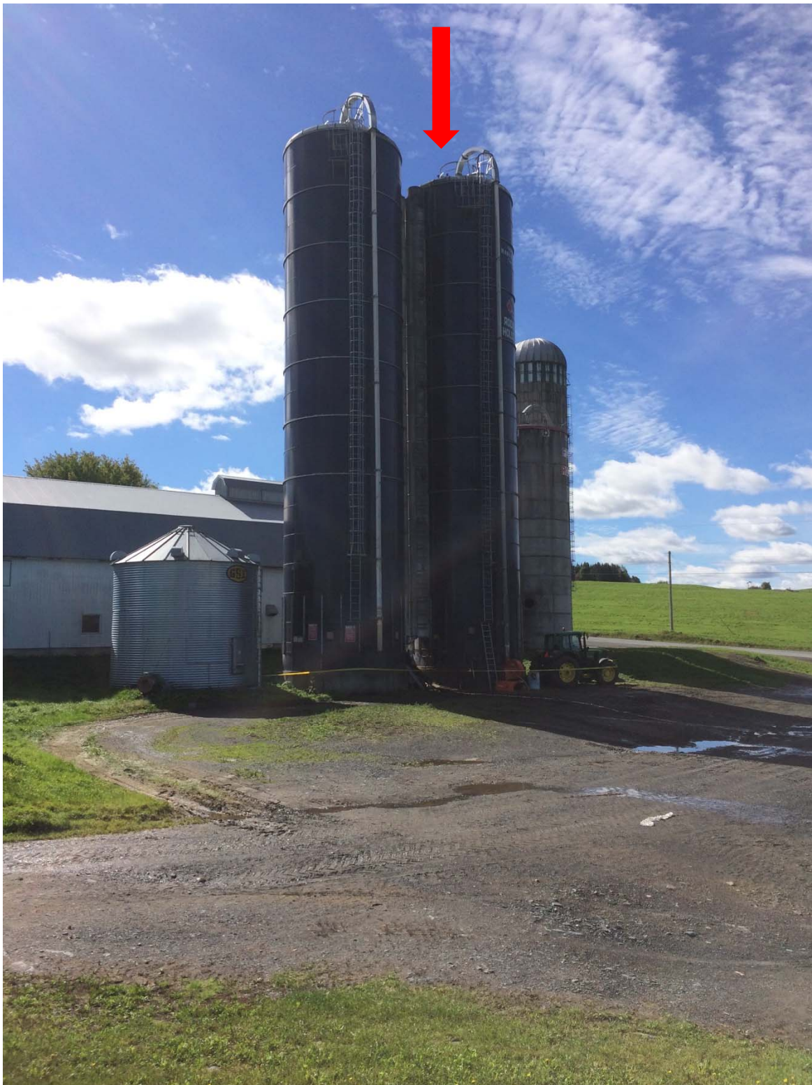
Photo 1 – Vue d'ensemble du silo
