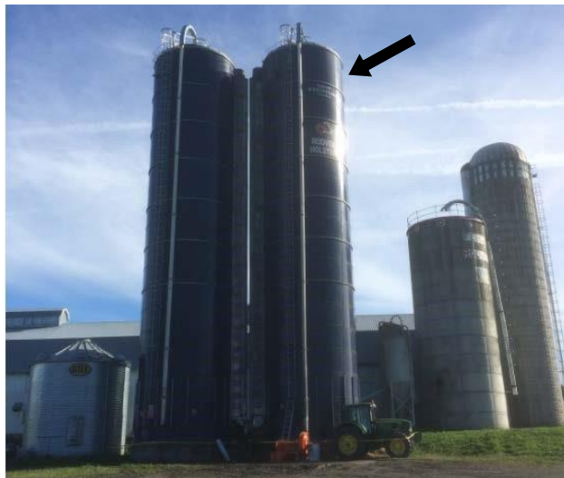
Photo 1 :Silo tour en cause (photo CNESST)
