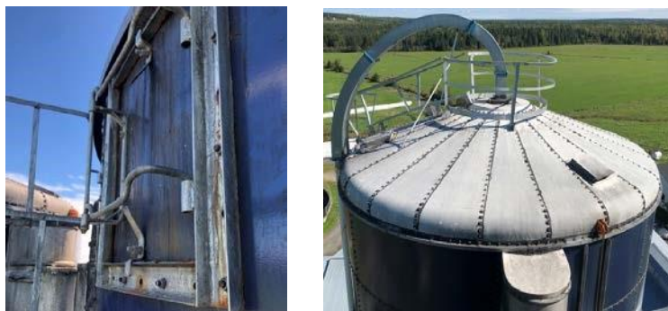
Photos 2 et 3 : Porte d'accès en haut de l'échelle extérieure et événements de toit (Photos : Groupe Gesfor)
