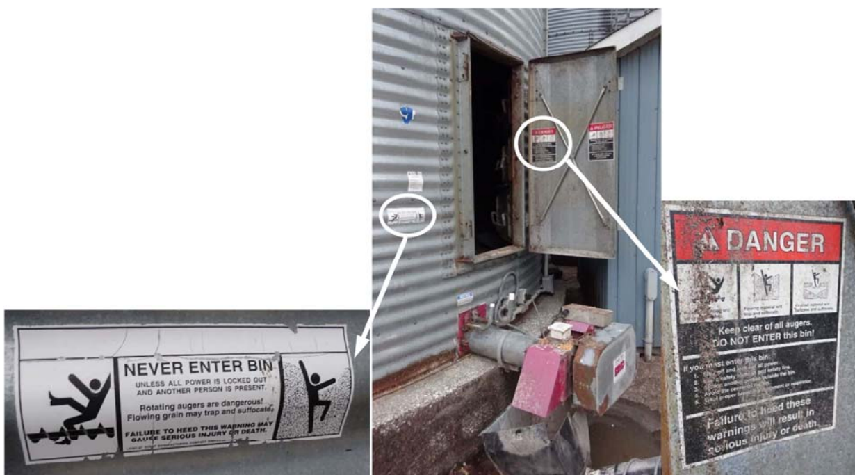
Fig. 11 - Vignettes près de l'entrée du silo-séchoir
